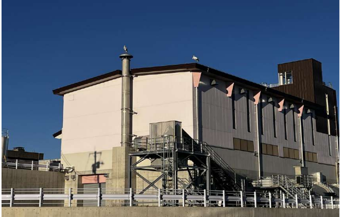
完成した与良川統合排水機場とコウノトリ 提供：栃木南部農業水利事業所
