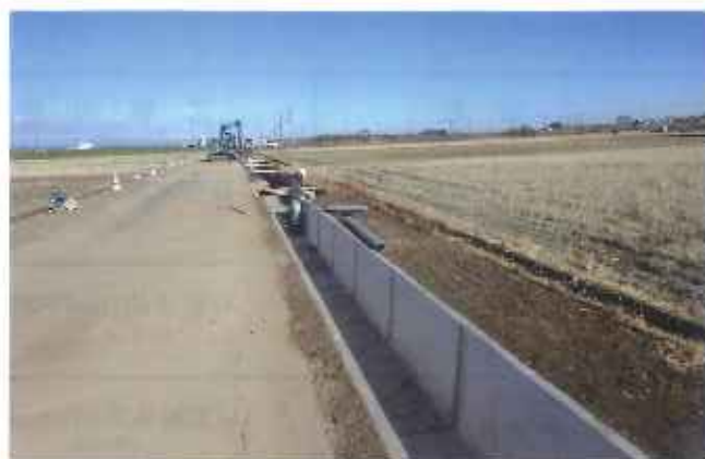
工事名 農業基盤整備促進事業 思川西部(6)地区 藤塚 水路工事 (工事内容はP.5のとおり)
