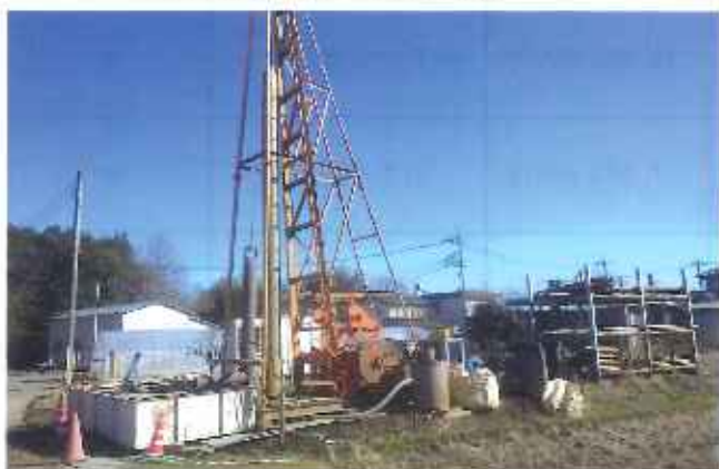
工事名 農地耕作条件改善事業 思川西部(7)地区 生良 揚水機工事 (工事内容はP.5のとおり) ※他同工種で白鳥・今里・北武井・田万・鏡を実施
